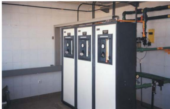
Sistema de inyectores de la dosificación de cloro gas. El control de dosificación es completamente automático.
