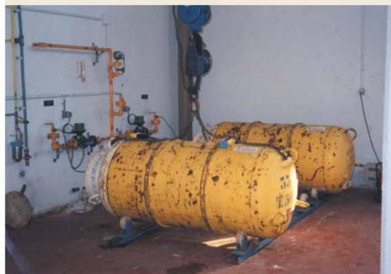
Botellones de cloro gas de un sistema de cloración. La disposición típica es una botella en funcionamiento y otra de reserva que funciona automáticamente al agotarse la primera.
